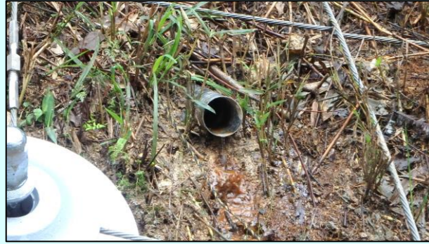
自然斜面 (ユニットネット工法併用)
